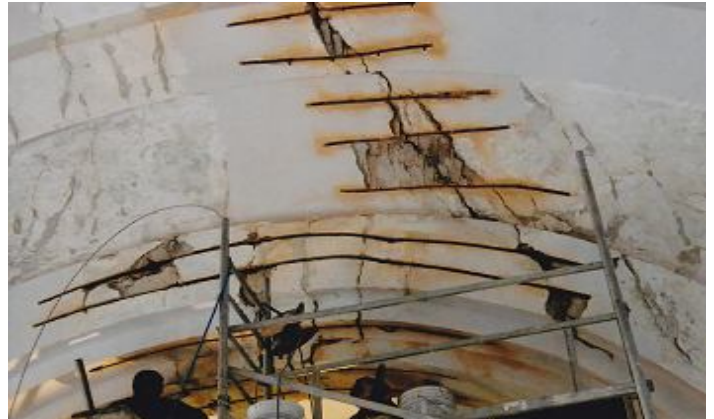
( A repedések összevarrása )
